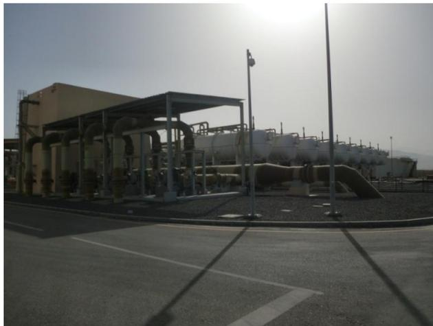
**Figura 8.30** – Vista parcial de usina de dessalinização de porte médio em Sur (Oman), com capacidade de produção de 80mil m<sup>3</sup> de água doce por dia (2012).
